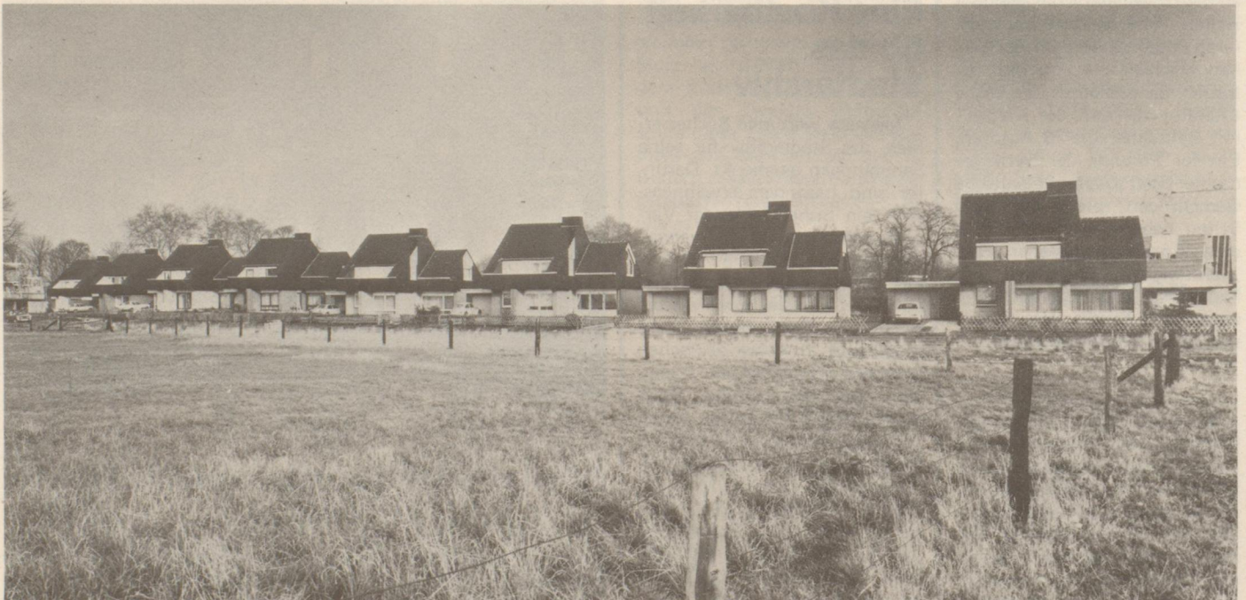
Eigenheime der HgB auf dem Gelände hinter Haus Caldenhof – ein Schmuck für die Landschaft, eine gelungene architektonische
