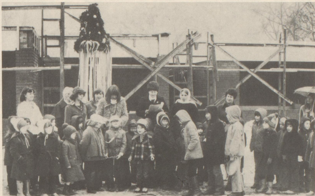
Richtfest an der Kindertagesstätte Sylverberg. Für 1,5 Millionen DM entsteht an der Elchstraße eine moderne Einrichtung.
