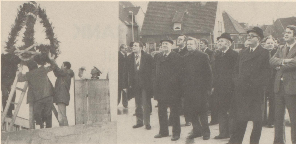
Der Richtkranz weht über der Tiefgarage am Chattanoogaplatz.
