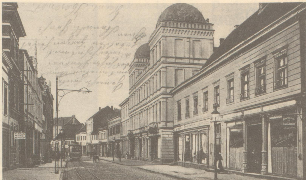
1907 beherrschte das Geschäftshaus mit den beiden Kuppeln die jetzige Hammer Fußgängerzone (heute: Leineweber). Rechts vorn das beliebte Restaurant „Stadt Düsseldorf“.
