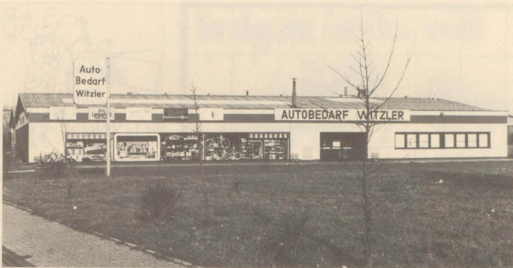
Der Neubau der Firma Witzler im Hammer Westen bietet auf 1500 Quadratmeter Lager- und Verkaufsflächen ein über 10 000 Artikel umfassendes Sortiment.
