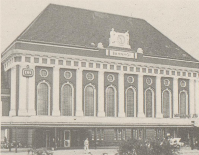
Bahnhof: ein ästhetisch gut gestalteter Zweckbau – der Bahnhof von Hamm in Westfalen; Inbetriebnahme 1920, Renovierung 1969/70
