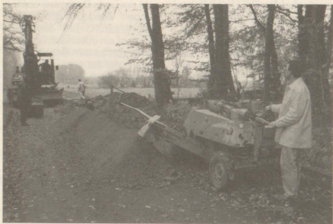
„Im Bremsen“ hat die Trinkwasserversorgung der Stadtwerke die Fräse erstmals für Verlegearbeiten einer Wasserleitung eingesetzt.
