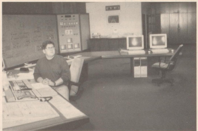
Die Netzleitstelle ist das Gehirn der Hammer Stromversorgung. Sie ist rund um die Uhr besetzt. Hier treffen alle Störungsmeldungen ein und von hier aus werden die Störungsbeseitigungen koordiniert.
