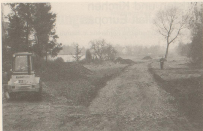
Ab „Am Pilsholz“ entsteht die Radweg-Haupttroute bis zur Eschenallee.
