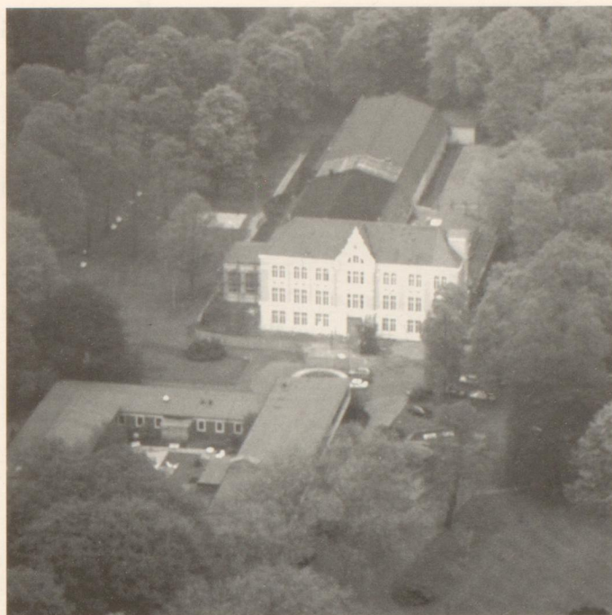
Aus der Luft gesehen sticht die Fassade des Kurhauses angenehm hervor, die Anbauten dahinter weniger.
