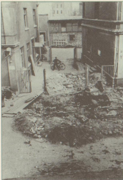
Durch Kriegseinwirkungen war besonders die Stromversorgung in Mitleidenschaft gezogen.
