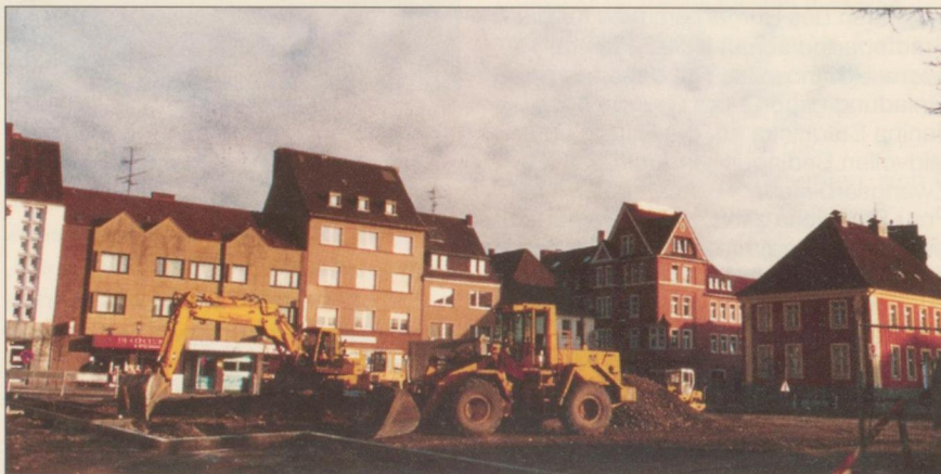
Die gegenwärtige Umgestaltung des Santa-Monica-Platzes ist ein weiterer Meilenstein für die Aufwertung der Hammer Innenstadt. Die voll im Terminplan befindlichen Bauarbeiten sollen bis zum Spätsommer abgeschlossen werden. Die neue Santa-Monica-Platz wird sich dann nahtlos in die Kulisse der ebenfalls neu gestalteten Südstraße und des Marktplatzes mit renovierter Pauluskirche und umgebautem Sparkassengebäude nahtlos einfügen.
