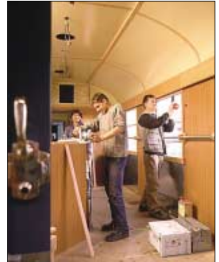
Innenausbau durch Auszubildende.
