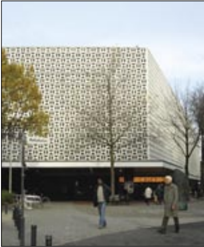
Problempunkt im Bahnhofsviertel.
