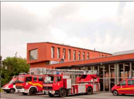
Schnelle Hilfe: Die neue Feuerwache Ost
