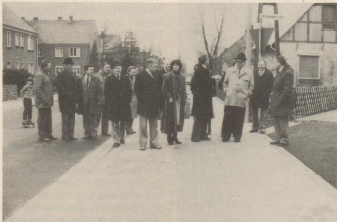
Nach Fertigstellung wurde die Blücherstraße in Hamm-Bokum-Hövel von Politikern, Verwaltungsfachleuten und Vertretern der beteiligten Baufirmen abgenommen.
