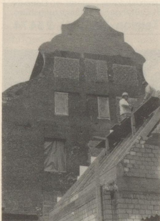
Die Baustelle Stunikenhaus — von der Hofseite her gesehen.
