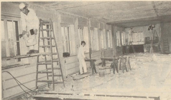
In dieser Werkshalle der ehemaligen Maschinenfabrik Rüter richtet das Kolping-Bildungswerk vom 1. Februar an 30 Trainingsplätze für Arbeitslose ein.
