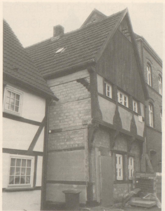
„Der Giebel auf Knaggen vorgkragend“ — hier besonders gut zu erkennen am Reginenplatz.
