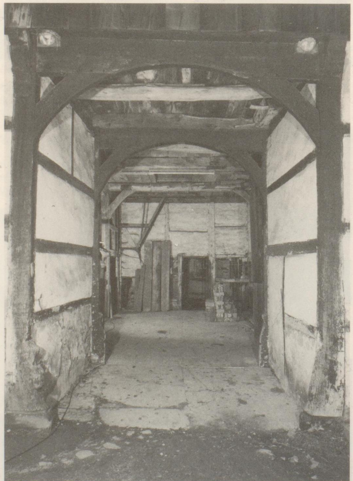
Die Innenkonstruktion des Hauses Busmann — hier während der Restaurierung — entspricht noch fast völlig der ursprünglichen Bauweise.
