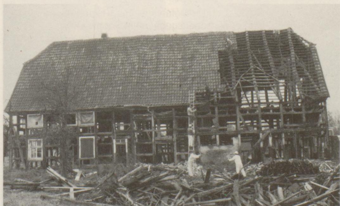
Das Haupthaus Crüsemann während des sorgfältigen Abbaus von Hand. Hier werden die Dachplatten gerade einzeln abgenommen und gelagert.
