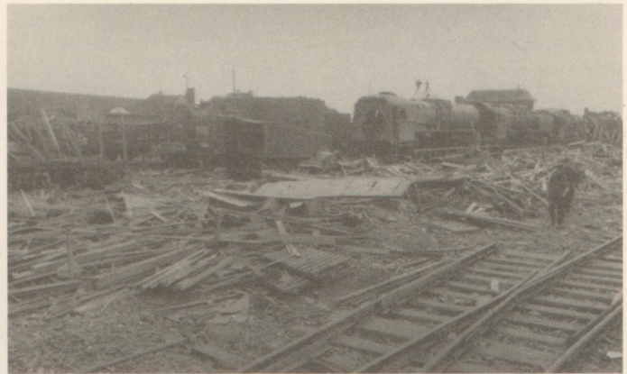
Schäden im Bahngelände 1943 — die schlimmste Phase des Luftkrieges begann jedoch erst 1944.
