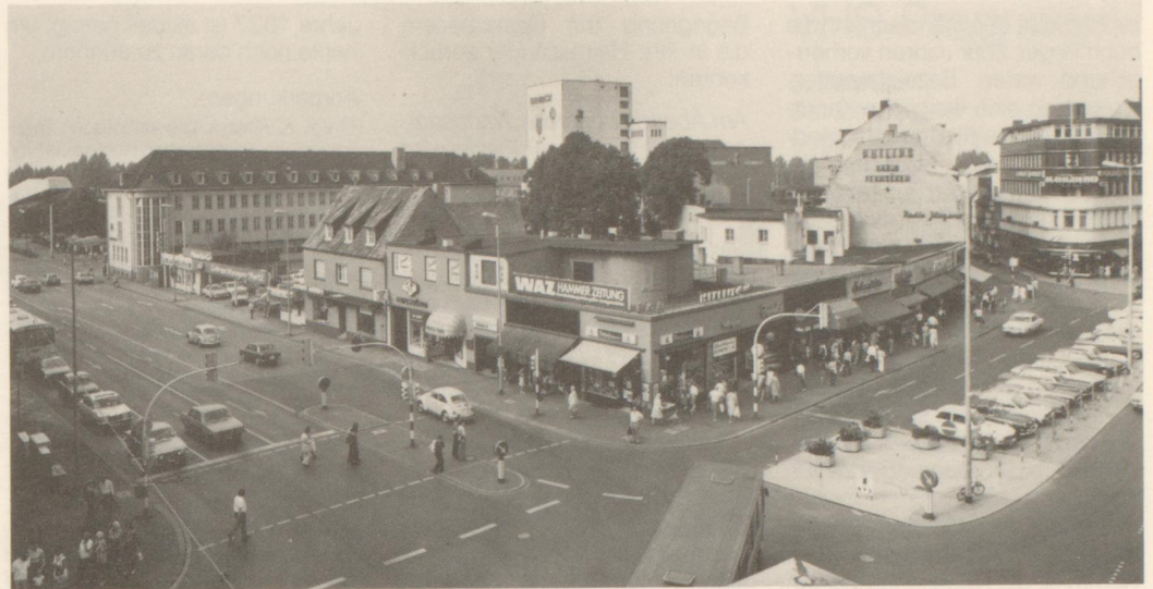
Der Wiederaufbau hatte teilweise eine ungeordnete städtebauliche Entwicklung zur Folge, die inzwischen — hier die ehemalige Bebauung des City-Centers — wieder beseitigt wurde.
