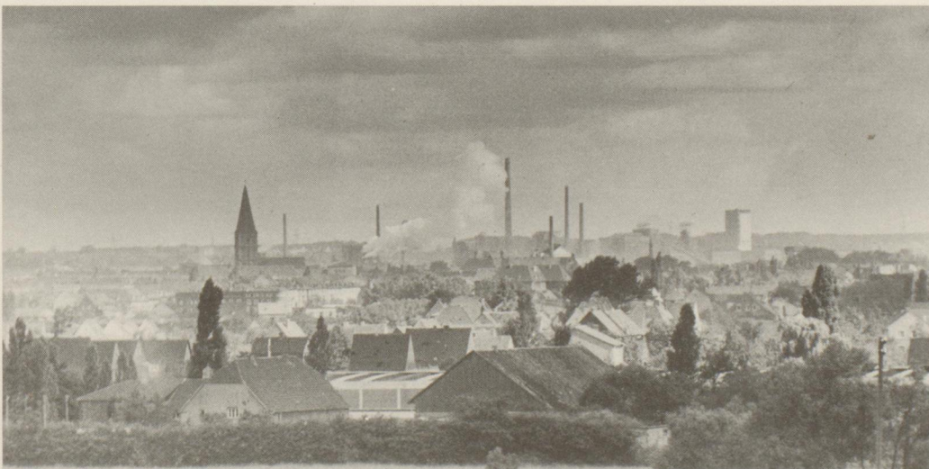
„Qualmende Schloten“ verkündeten noch Anfang der 60er Jahre vom deutschen Wirtschaftswunder, von Umweltschäden sprach noch fast niemand. Im Hintergrund die ehemalige Zeche Sachsen.
