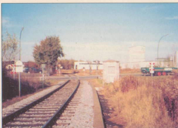
Heute haben sich östlich der noch vorhandenen Gleise Gewerbebetriebe angesiedelt. Vielleicht wird hier einmal die Stadtbahn fahren.
