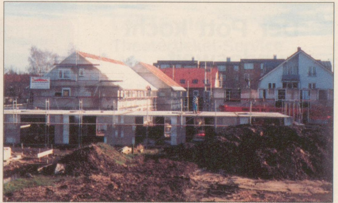
In mehreren Baugebieten in Hamm entstehen z. Z. neue öffentlich geförderte Wohnungen.
