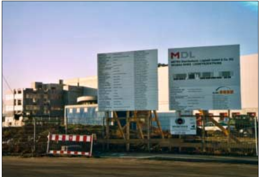
Geht bald im Hammer Westhafen in Betrieb: Das neue Distributions- und Logistikzentrum der Metro-Gruppe für die Märkte in Nordrhein-Westfalen und den angrenzenden Gebieten. 400 Arbeitsplätze werden hier geschaffen.
