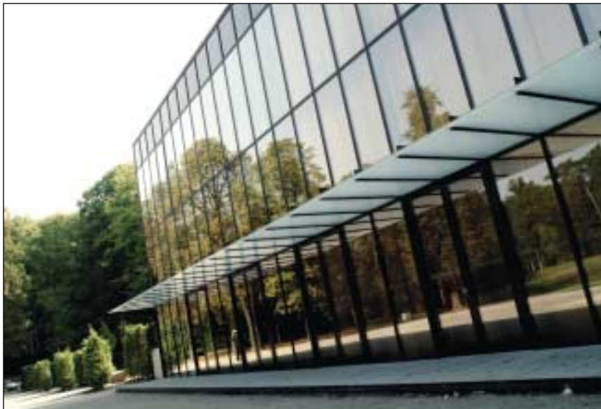
Komposition aus Stahl und Glas: Das neue Kurhaus Bad Hamm.
