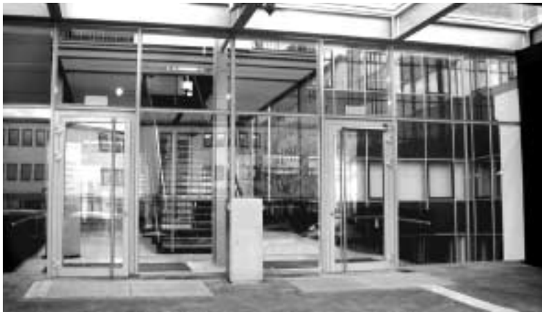
Das Technische Rathaus der Stadt Hamm wurde über DAL-Kommunal-Leasing realisiert
