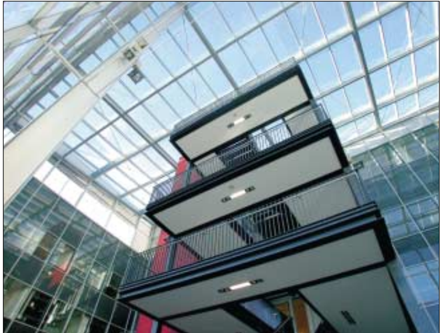
Stahl und Glas dominieren die optisch hochwertige Architektur. Fotos: Feußner
