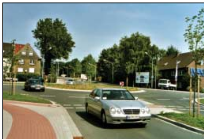
Münsterstraße: Eindeutiger Fortschritt.
