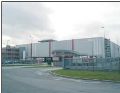
Logistik: Auch Trinkgut bald im Westhafen, in Nachbarschaft zur Metro.
