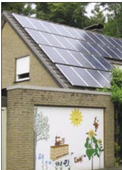
Auf Hammer Dächern: Fotovoltaik.
