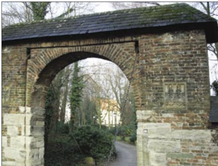
Torbogen mit vorgelagerter Brücke: Die Zufahrt zum „Haus Reck“.
