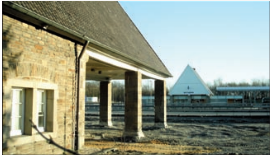
Die ehemalige Tankstelle Rhynern-Nord: Die Zapfsäulen wurden demontiert.
