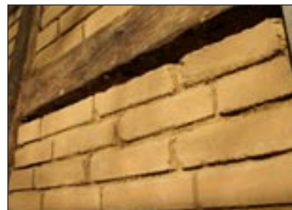
Zum Richtfest: der Holznagel – Die beim Trocknen entstandenen Fugen (unten) werden mit Lehm verputzt.
