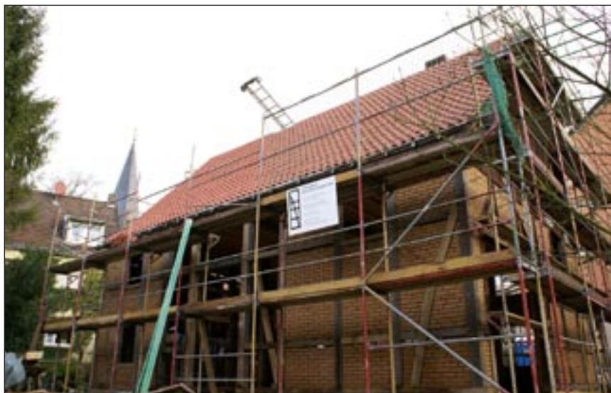
Von außen fast schon fertig: Das Fachwerkhaus am Marker Kirchplatz.
