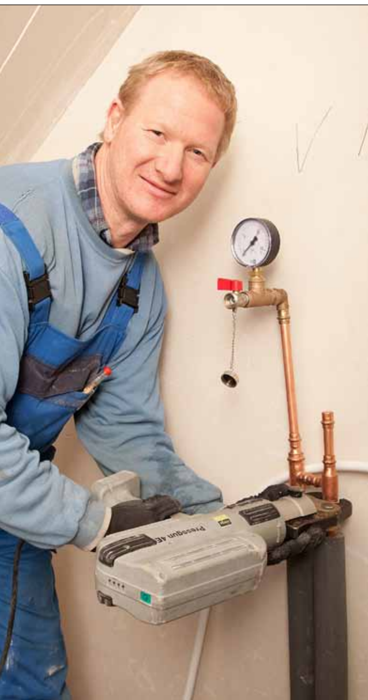
Schweißen war gestern: Moderne Installationstechnik im Einsatz
