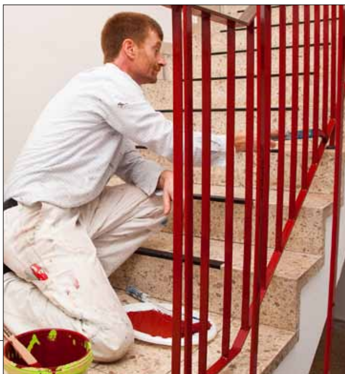
Farbenfrohe Ergebnisse: Malerbetrieb Lehmkemper bei der Arbeit
