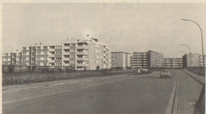
Moderne Skyline: Wohnblocks im Bereich der früheren Gemeinde Werries des Stadtteils Uentrop.
