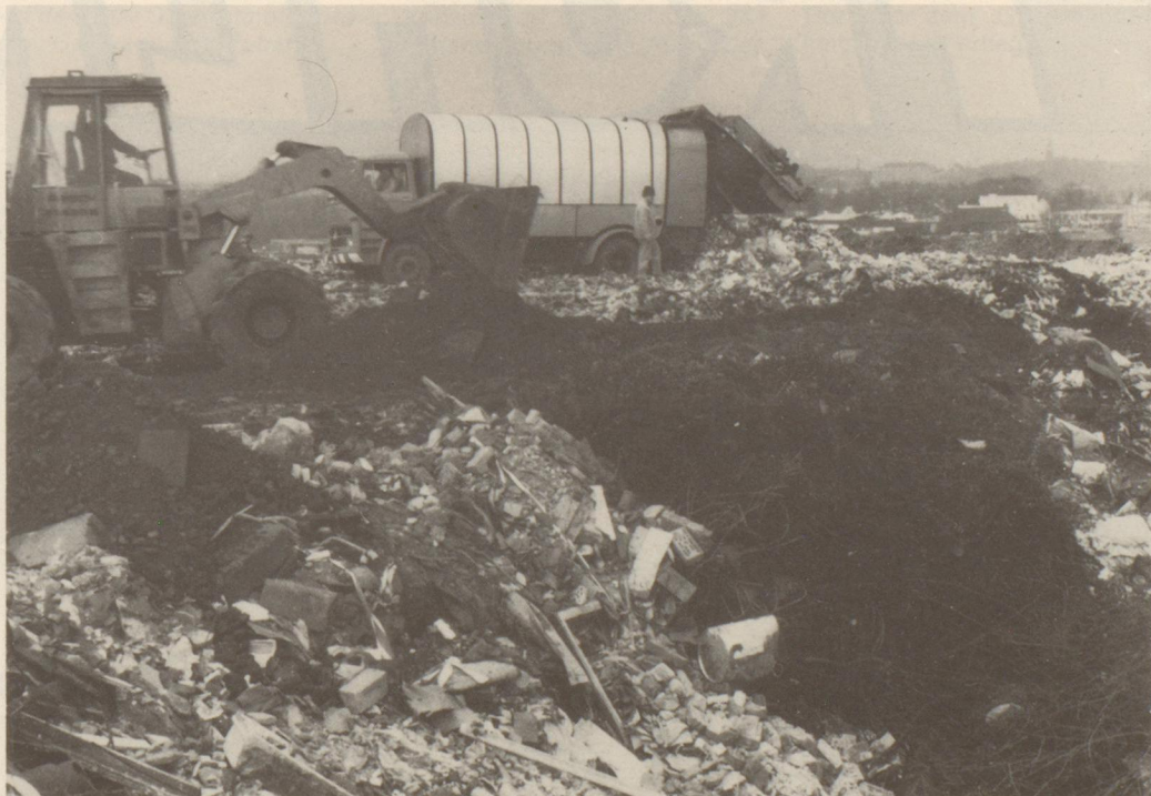
Kurz vor der Schließung: Die alte Mülldeponie an der Bromberger Straße.
