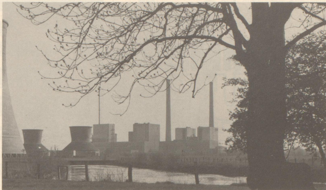
Hamm — Energiezentrum einer großen Region. Unser Bild zeigt das Kraftwerk Westfalen im Osten der Stadt. Foto: Klimmer
