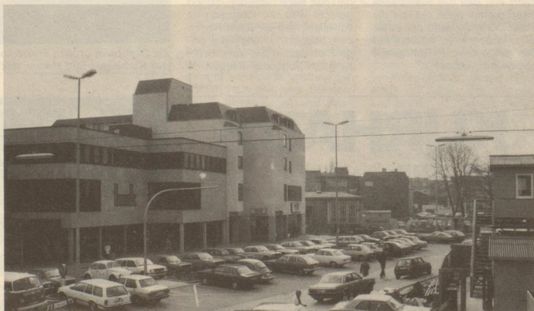
Teilweise schon fertig: Die neue Bahnhofstraße, die zur Zeit noch zum Parken benutzt wird.
