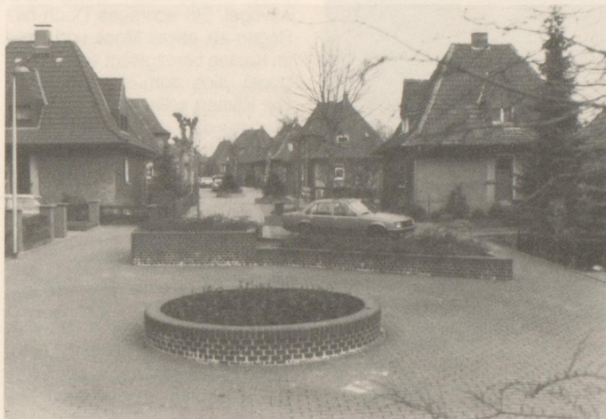
Durch den Einbau von Hochbeeten wurde der „Schleichweg“ Rosa-Luxemburg-Straße in Hamm-Heessen unterbunden. Die Fahrzeuge bleiben auf den Hauptverkehrsstraßen.
