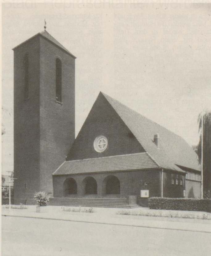
Wehrhaftigkeit und Glaubenstreue strahlt der Kirchenbau St. Johannes aus.
