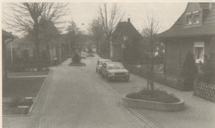
Die Verkehrszeichen „Verkehrsberuhigter Bereich“ und „30 km/h-Zone“ tragen ebenso zur Verkehrsberuhigung bei wie ergänzende Straßenumbauten, wie hier als Mischfläche in der Rosa-Luxemburg-Straße.
