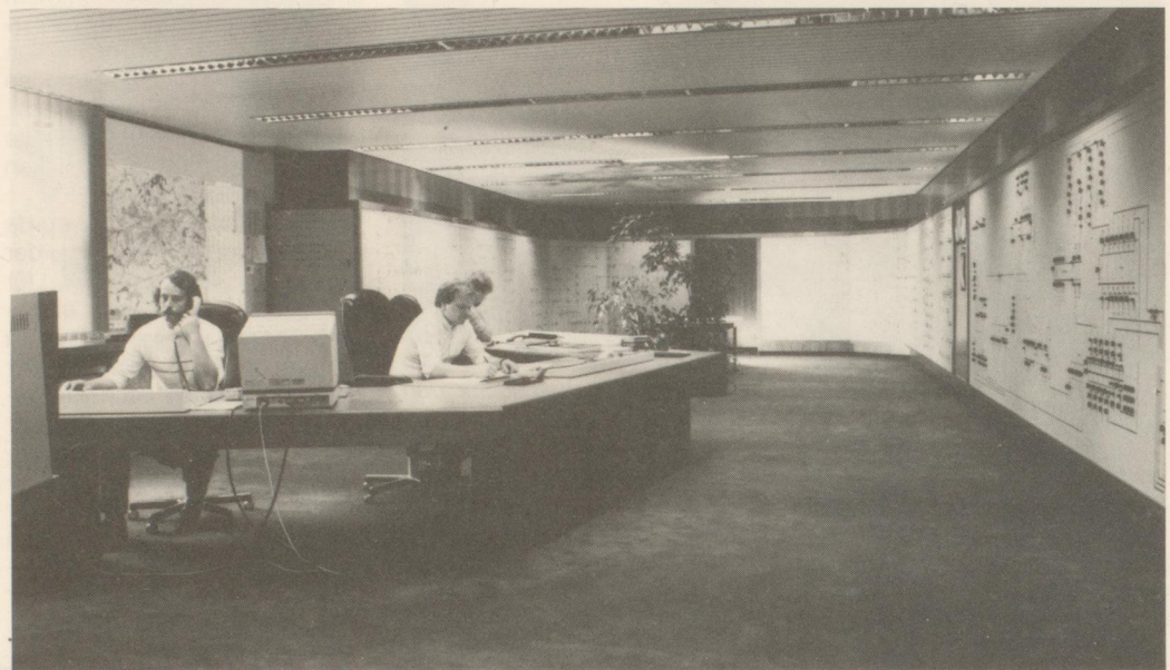
Hier in der Netzleitstelle wurden die Störmeldungen aufgenommen. Von hier aus wurde der Einsatz des mobilen Entstörungs- und Bereitschaftsdienstes gesteuert.
