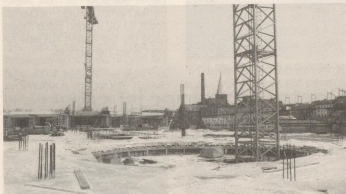
Über diese Stelle wird sich bald die Lichtkuppel erheben.
