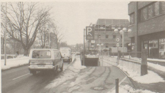
Das öffentliche Parkhaus Südring/Sedanstraße, seit Oktober unter neuem Management, bietet in drei Tiefgeschossen Parkraum für ca. 300 Fahrzeuge. Im 3. UG für Dauerparker, im 2. UG für Kurz-/Tagesparker und im 1. UG für die Mieter des Bürogebäudes. Die Parkgarage wird mit Video-Kameras überwacht und hat ein codiertes Ein- und Ausfahrkontroll-System. Eine Tageskarte kostet z. Zt. maximal DM 9,-.
