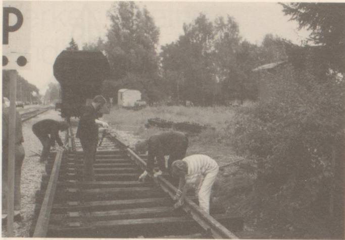
Schwerarbeit ist der Austausch der Schwellen für die Hammer Eisenbahnfreunde.
