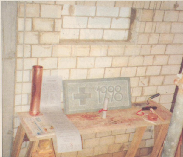
Der Grundstein wird in die Wand des Eingangsbereiches eingelassen.
