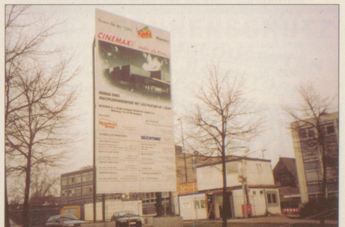
Eine Vorstellung vom CinemaxX gibt das Bauschild am Chattanoogaplatz.
