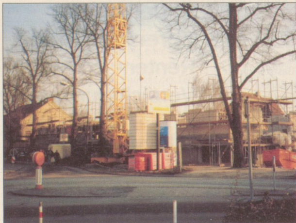
Am Ostenwall wächst schon der 2. Stock des DRK-Gebäudes heran. Fertigstellung ist im Sommer 1999.
