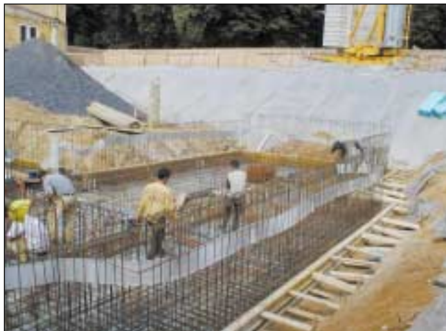
28.08.2001: Die Stahlbetonplatte wird gegossen.
