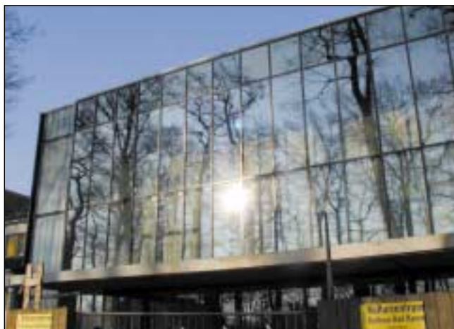
09.12.2002: Die fertige Stahl-/Glas-Fassade. Fotos: Weige
