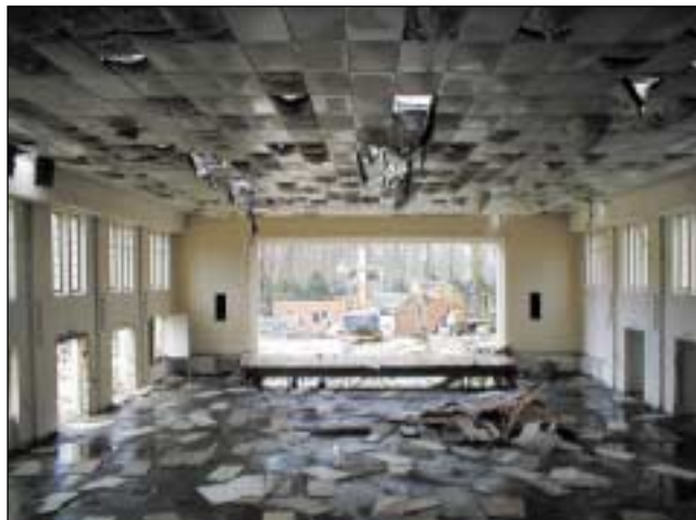
19.03.2001: Der alte Theatersaal wird abgerissen.
