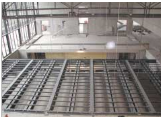
05.11.2002: Der Innenausbau nimmt Gestalt an.
