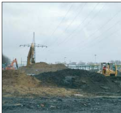
Entlastung: Kanaltrasse im Ausbau.
