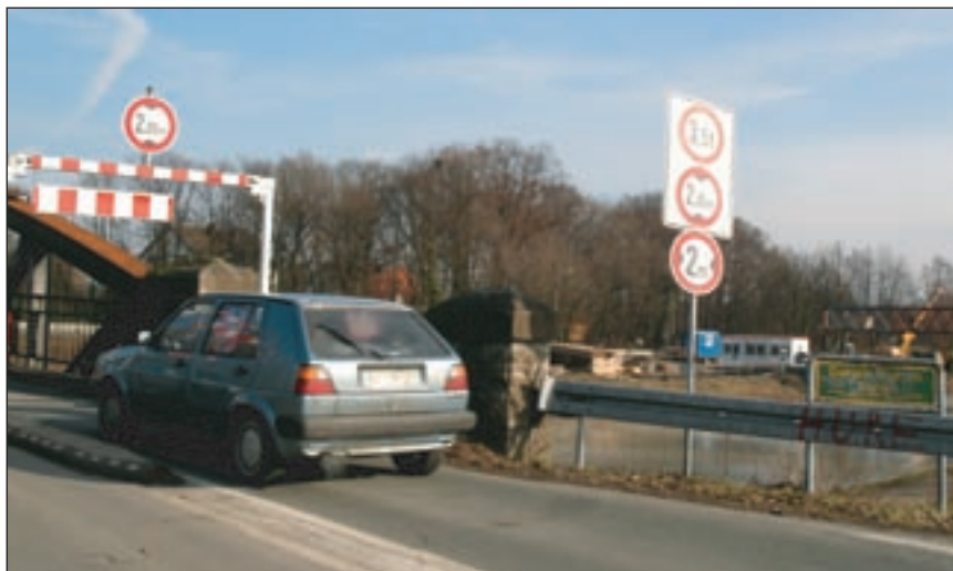
Die Maximilianbrücke zwischen Werries und Uentrop wird neu gebaut.
