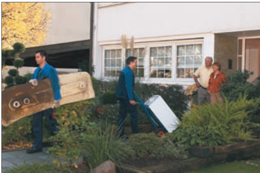
Der Austausch eines alten Ölkessels gegen eine moderne Gasheizung ist rasch erfolgt. Der Öltank wird vor der Entsorgung gereinigt, zersägt und in Einzelteilen aus dem Haus getragen. Dabei fällt kaum Schmutz an. Bild: BGW
