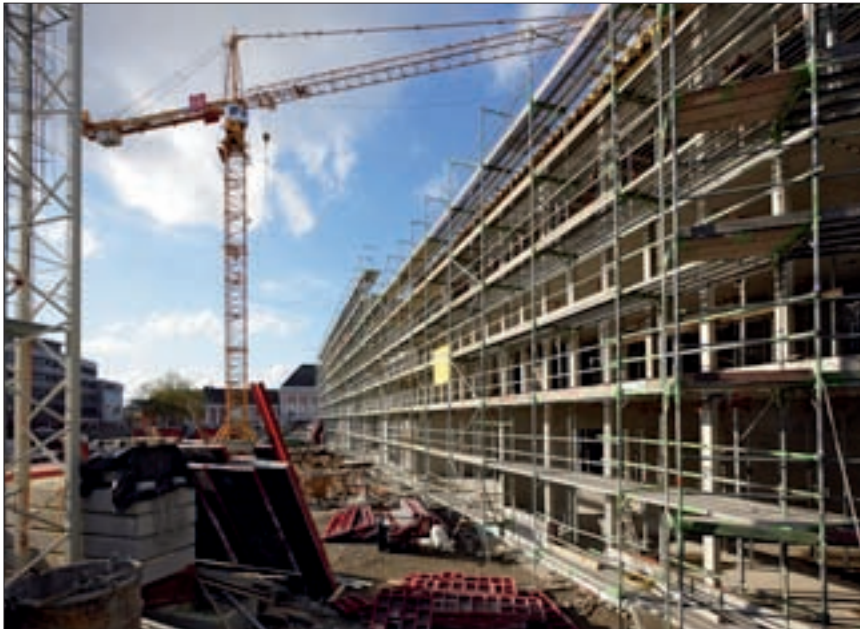
Die Großbaustelle des Heinrich-von-Kleist-Forums.
