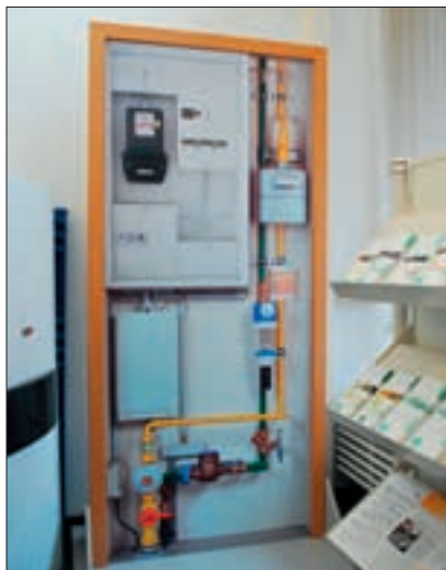
Die kompakte Hausanschlussnische.
