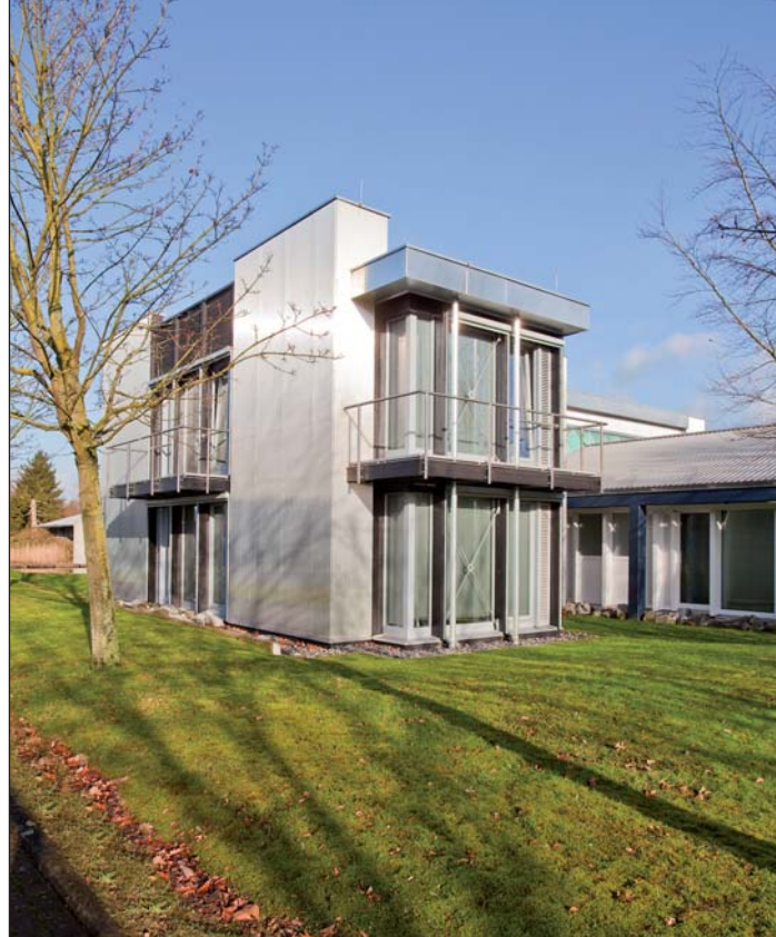
Der Turm des Bürogebäudes im Gewerbepark Rhynern
