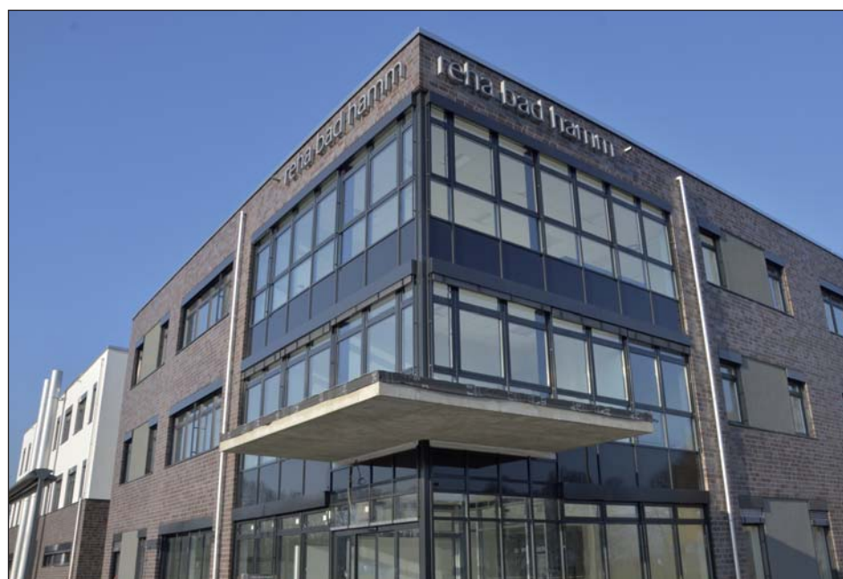
Die neue Reha Bad Hamm an der Arthur-Dewitz-Straße
