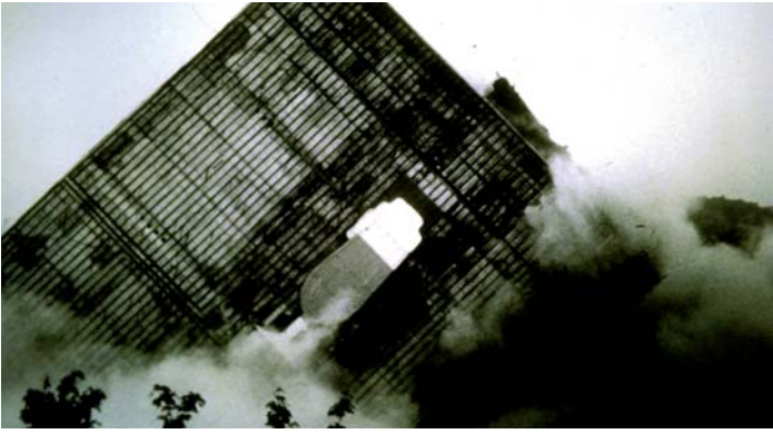
Im April 1990 begannen auf dem Gelände der Brauerei Isenbeck die Abbrucharbeiten, um Platz für das neue Center zu schaffen.
