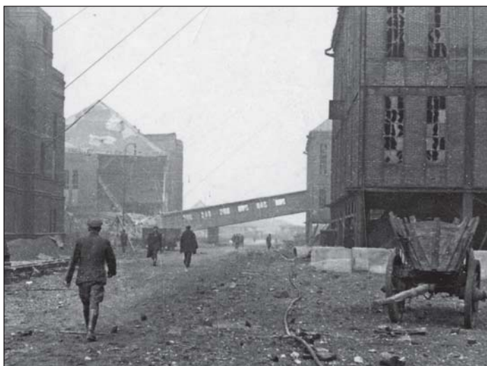
Das Gelände der Zeche Sachsen nach dem Bombenangriff vom 27. März 1945.
