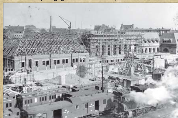
Das neue Empfangsgebäude in der Bauphase
