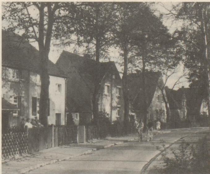
Sie soll saniert werden: Die Maximilian-Kolonie in Hamm-Werries.
