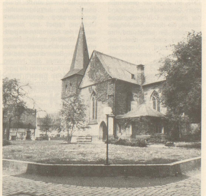
Alte Kirche in romantischer Umgebung: Die Marker Dorfkirche und der sie umgebende Platz bilden ein bemerkenswertes Ensemble. Der Denkmalschutz sichert heute den Bestand der Gesamtanlage auch für künftige Generationen.
