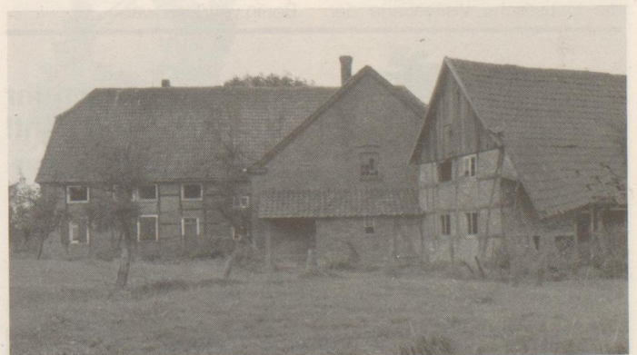
Die Gesamtansicht des Hofes Crüsemann — nur das Haupthaus im Hintergrund wurde zum späteren Wiederaufbau gerettet.
