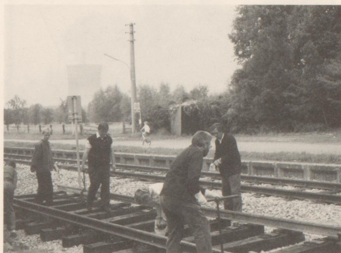
In Handarbeit wurden Schwellen der erworbenen Strecke erneuert.
