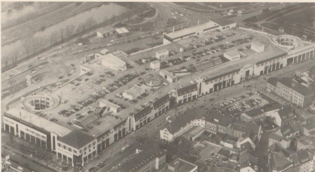
Auf dem Dach und eine Etage darunter befinden sich 1300 Parkplätze, die von Hafenstraße und Westenwall angefahren werden können. Das Foto spiegelt auch die Dimension des Gebäudekomplexes wider.
