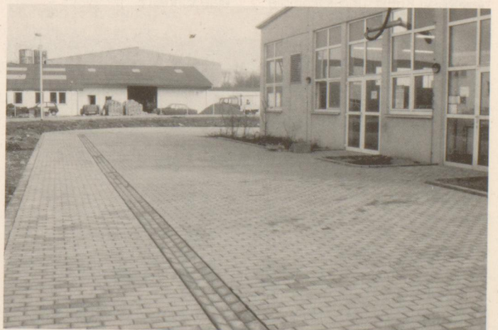
... das Umfeld des Wilhelm-Jost-Institutes an der Östlingstraße trocken und befestigten es.
